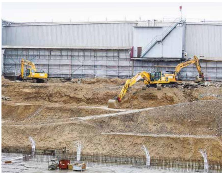
*Unten ist die Bodenplatte betoniert, oben stehen die Bagger weiterhin im Einsatz.*
