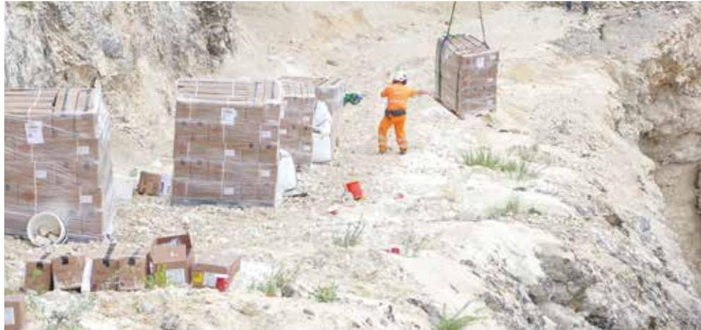
Über acht Tonnen Sprengstoff musste in den Bohrlöchern platziert werden.
