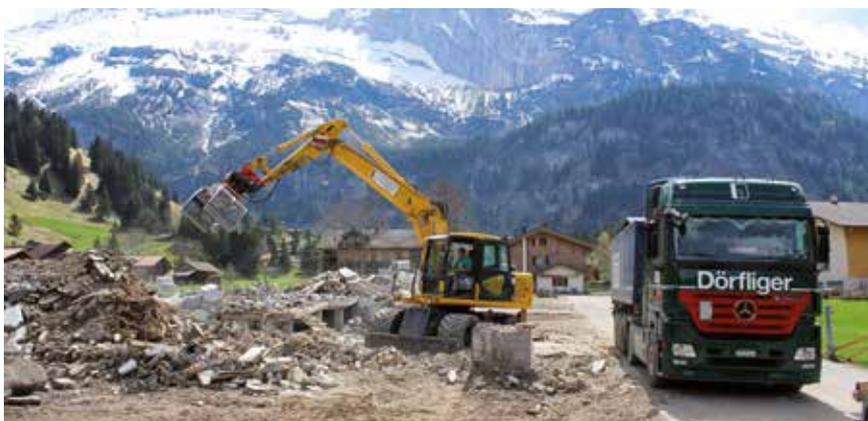
*Stück um Stück werden die Baracken zerlegt und das Material abgeführt.*
