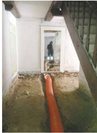
Boden aufbrechen und staubfreies absaugen
