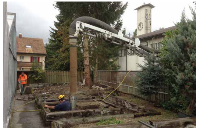
Graben- und Grubenaushub in Gärten etc.
