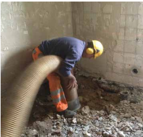
Boden aufbrechen und staubfreies absaugen
