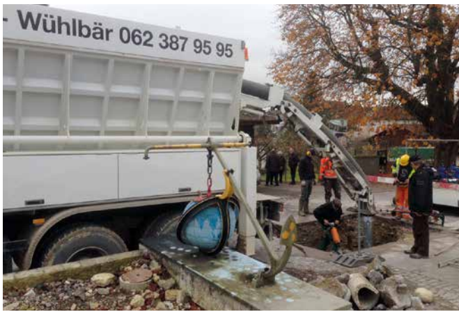
bei Wasserleitungsbrüchen mit Kompressorhammer
