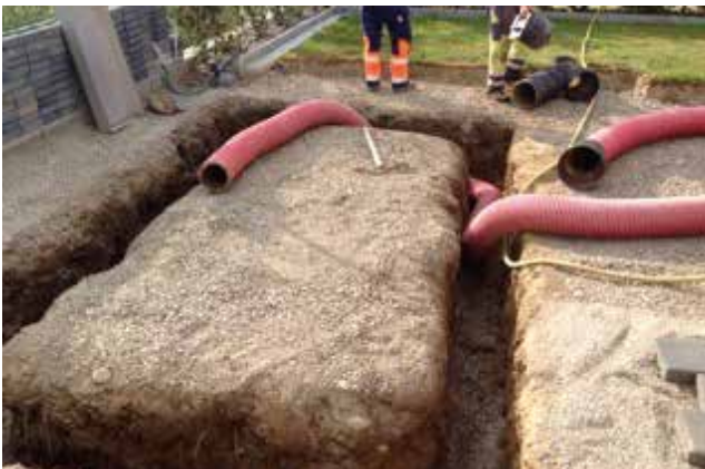
für genauen Fundamentaushub
